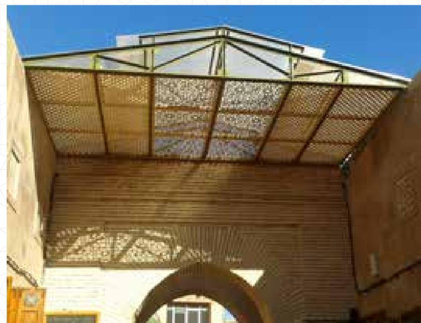
La couverture extérieure est composée de panneaux de polycarbonate
